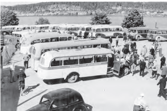
Arbeidsbusser venter utenfor Hydro på Herøya i 1960. Det var flere selskaper som fraktet arbeidsfolk til og fra Herøya. Foto: Porsgrunns museenes fotosamling.
