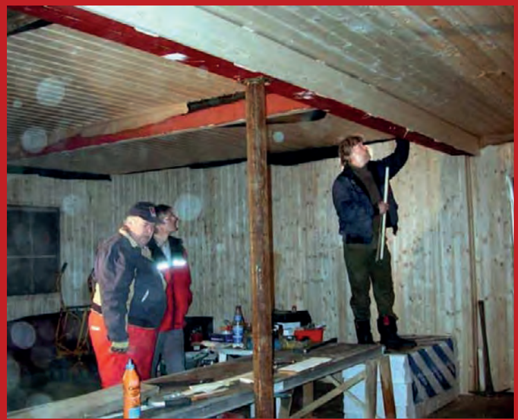
Jan Artur Pettersen, Hans Karl Hansen og Tormod Hansen fokuserer på gulvet i 1. etasje mens Knut Brekke, Sven Hansen og Stein Haugseter sørger for at bærebjelker i møtelokalet kan bære vekten av all aktivitet i 2. etasje.
